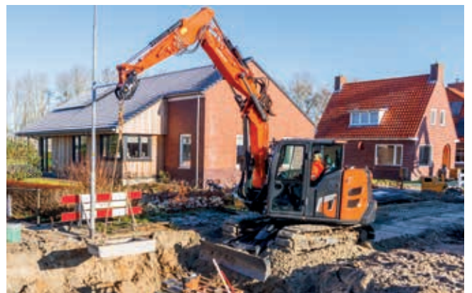
L'augmentation de la capacité de levage permet une plus grande polyvalence.
